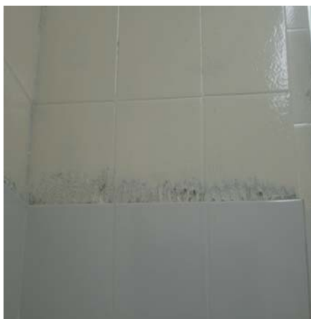
Fig. 13 – Banheiro da Direção - Detalhe do acabamento
