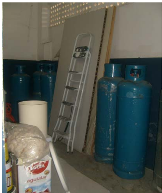
Fig. 15 - Botijão GLP armazenado em local inapropriado.
