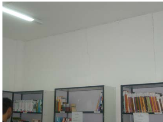
Fig 8: Sala de estudo - Massa trincada
