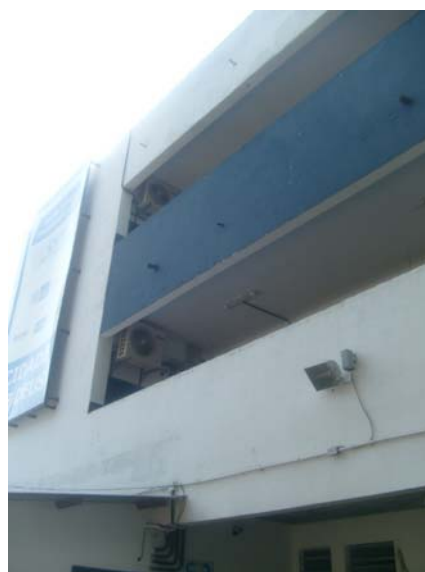
Fig 30 - Fachada - Buzinote jogando água na área externa.
