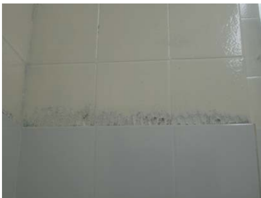
Fig. 13 – Banheiro da Direção - Detalhe do acabamento
