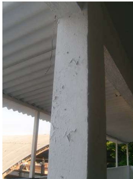
Fig.24 - Corredor 2 do 2ª Pav – Pintura deteriorada.
