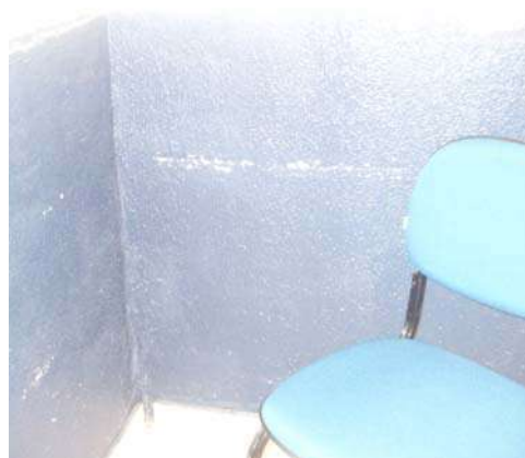
Fig 4: Recepção - Pintura danificada pelo mobiliário.
