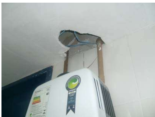
Fig 21 - Cozinha - Buraco no forro de gesso.
