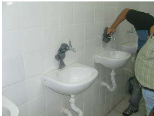
Fig 28 - Pias interditadas devido a vazamento no sifão.
