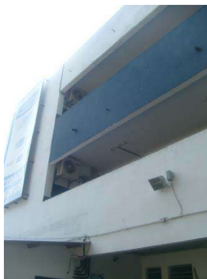
Fig 30 - Fachada - Buzinote jogando água na área externa.
