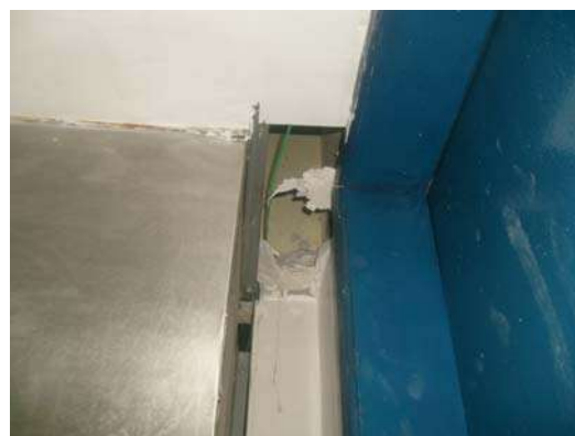
Fig 22 - Cozinha - Buraco no forro de gesso.
