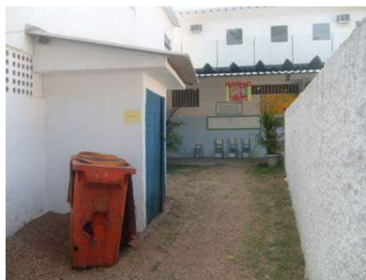
Fig 14 - Abrigo para gás sem ventilação suficiente.
