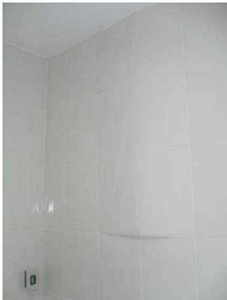
Fig 23 - Cozinha - Parede estufada
