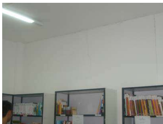
Fig 8: Sala de estudo - Massa trincada
