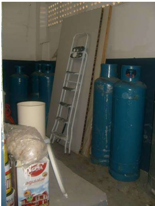
Fig. 15 - Botijão GLP armazenado em local inadequado.
