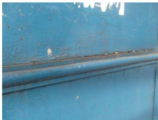
Fig 2: Detalhe do portão danificado por ferrugem
