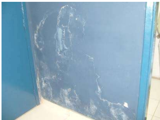
Fig 5: Adm – Pintura danificada pela infiltração.
