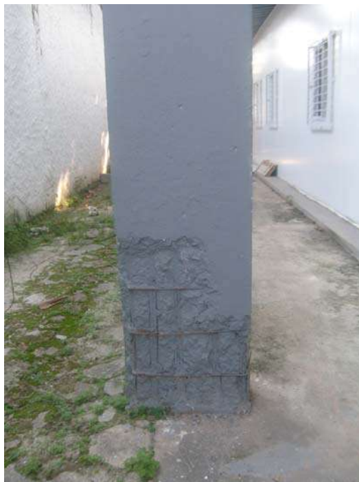
Fig. 16 - Armação aparente sem tratamento necessário.
