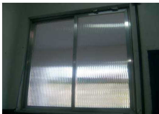
Fig 10: Janela de alumínio sem trinco
